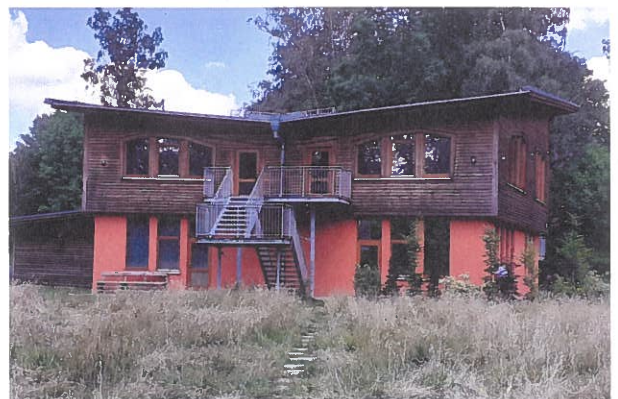
Oberstufenhaus Freie Waldorfschule Melle
